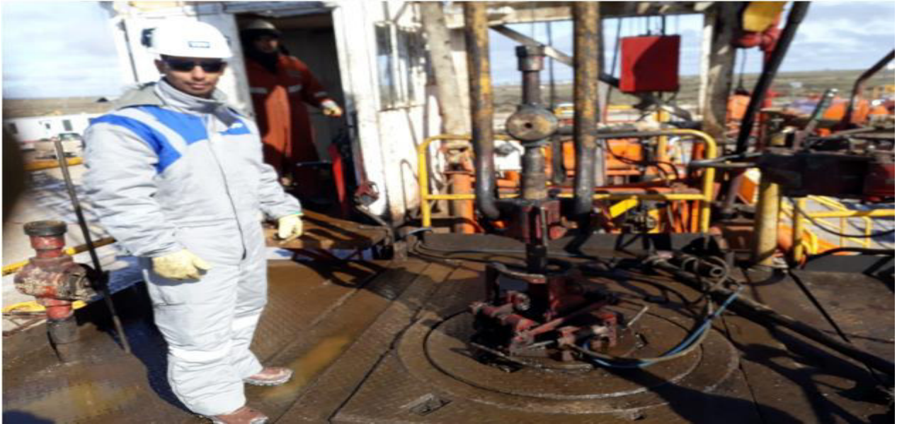
Foto 1. Piso de trabajo de equipo de Pulling (Foto propia).
