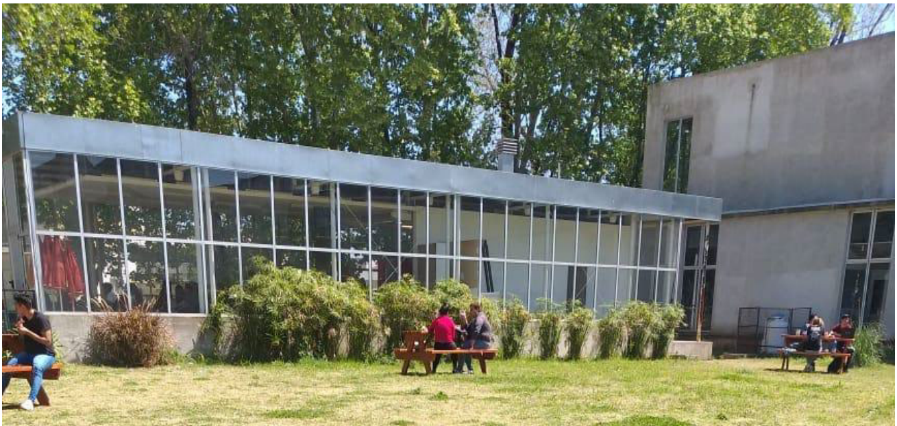
Imagen 1: Vista exterior del edificio.
