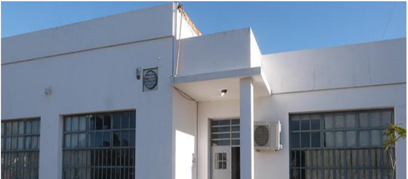
Imagen 1: Vista exterior del edificio.
