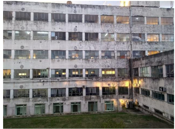
Imagen 2: Vista exterior del edificio.
