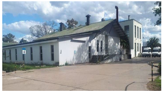
Imagen 6: Vista exterior del edificio.
