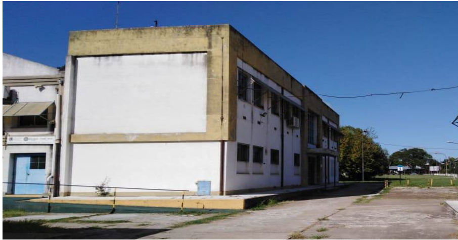
Imagen 2: Vista exterior del edificio.
