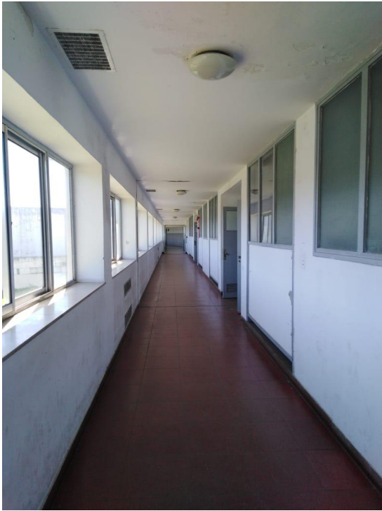
Imagen 7: Pasillo primer piso.
