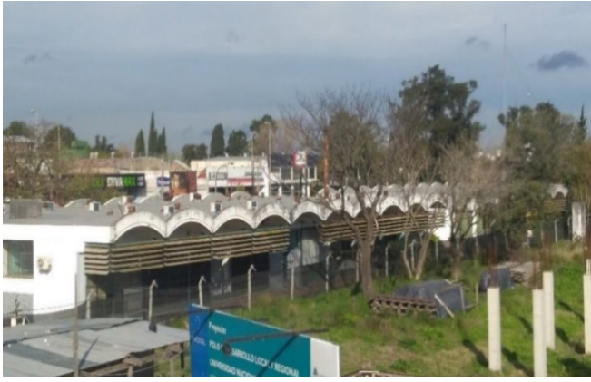
Imagen 12: Techo del edificio Ex LCV. (Fuente: Fotografía propia).
