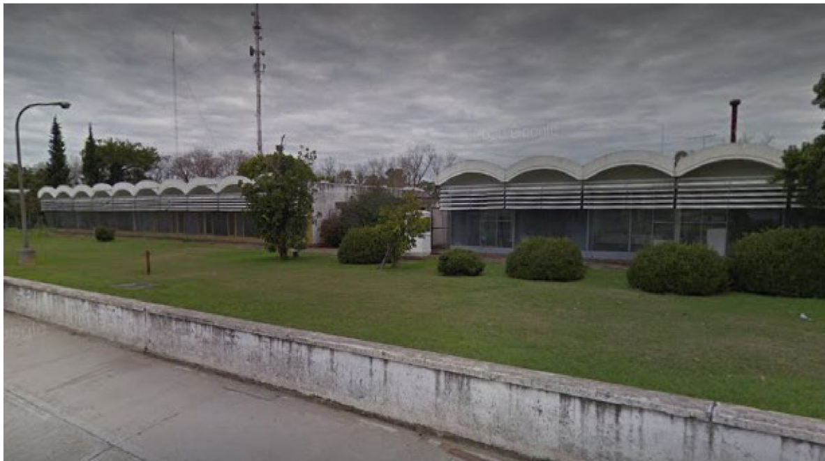
Imagen 1: Vista exterior del edificio.
