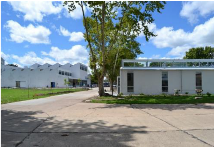
Imagen 2: Vista exterior del edificio.
