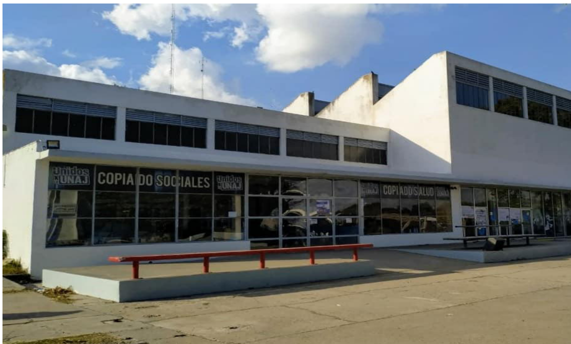
Imagen 2: Vista exterior del edificio.
