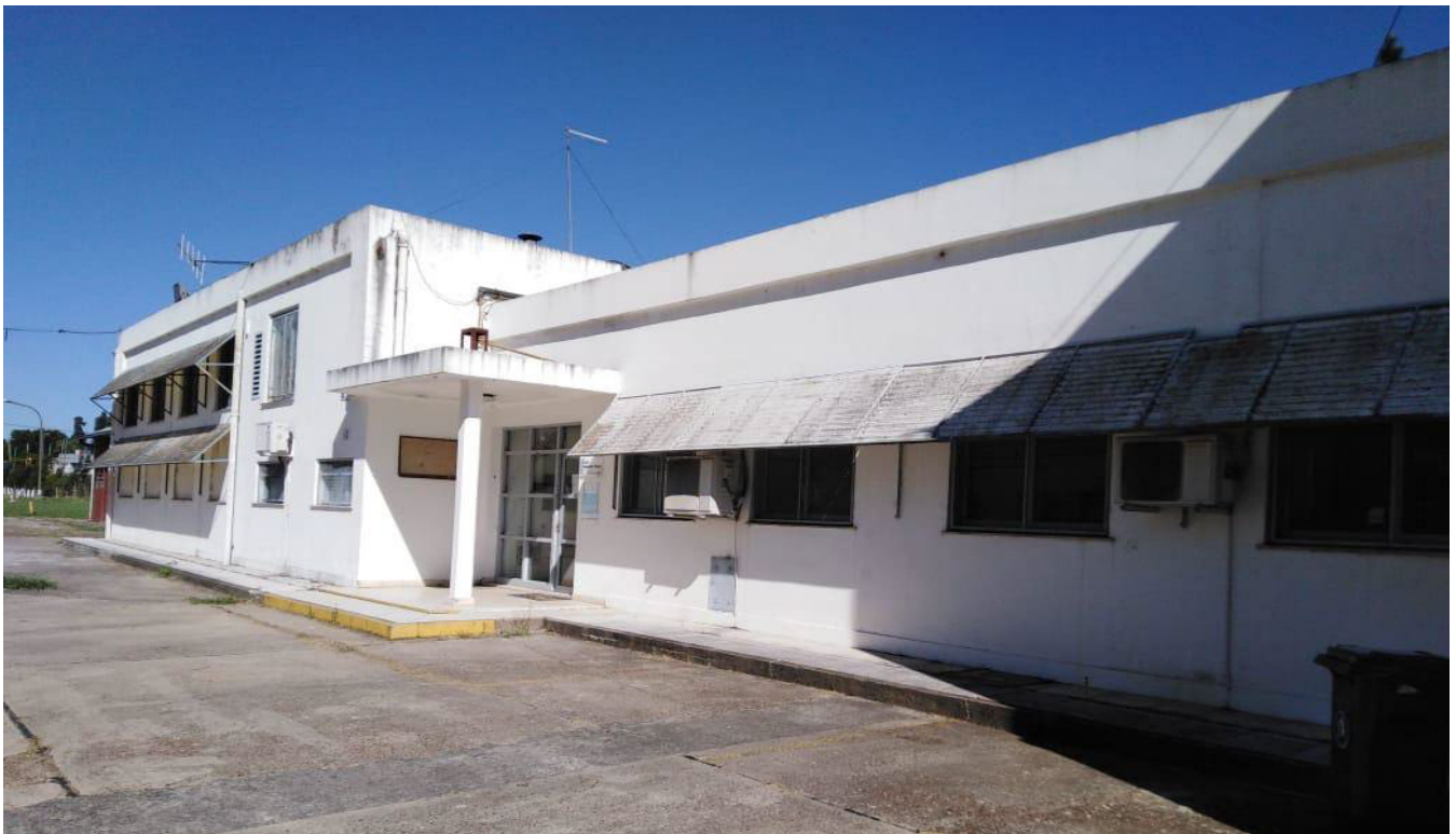
Imagen 1: Vista exterior del edificio.
