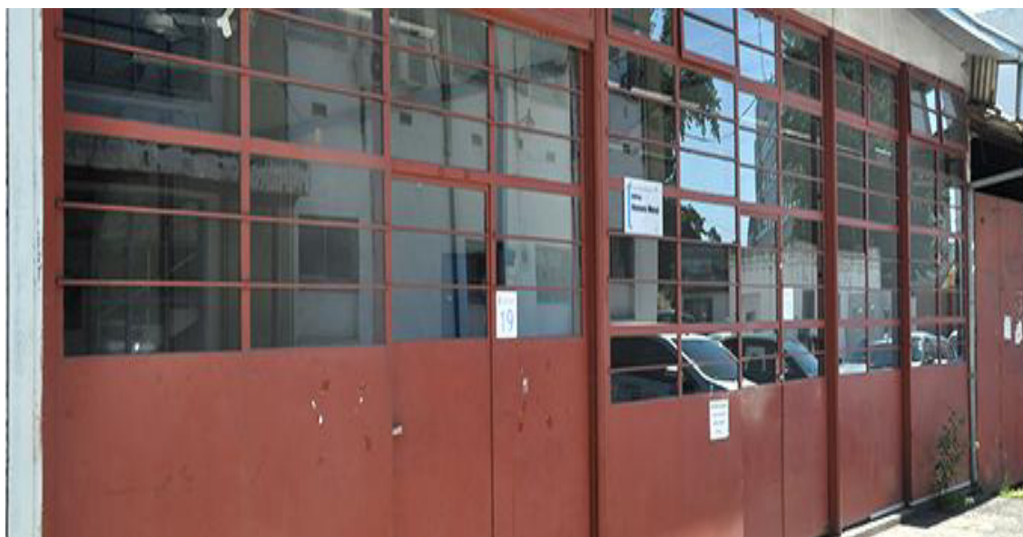
Imagen 1: Vista exterior aulas 18 y 19.
