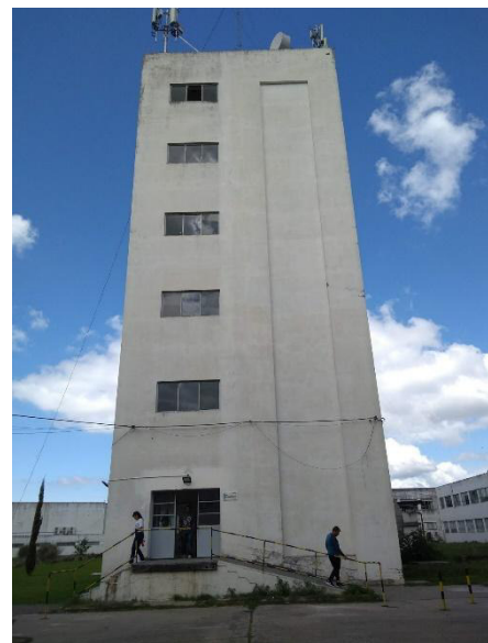
Imagen 4: Vista exterior del edificio.
