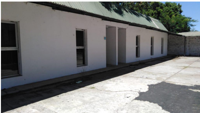
Imagen 5: Vista exterior de las aulas 11 y 12.
