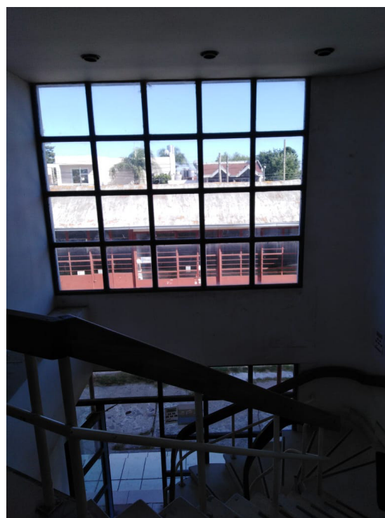
Imagen 6: Vista hall central del edificio Ugarte. (Fuente: Fotografía propia).
