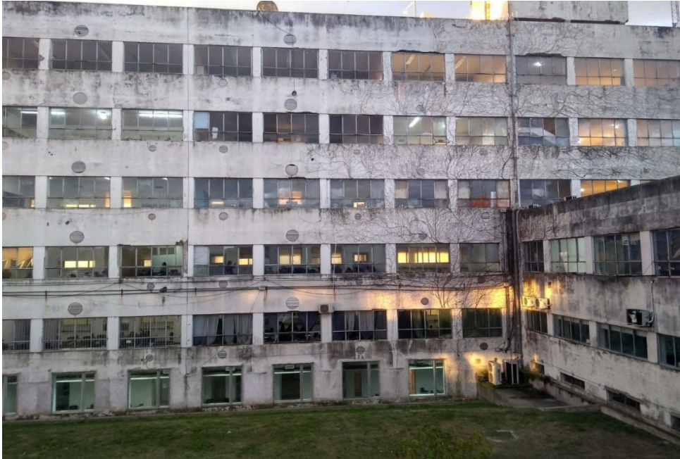
Imagen 11: Ventanas del edificio Mosconi. (Fuente: Proyecto GENUP)
