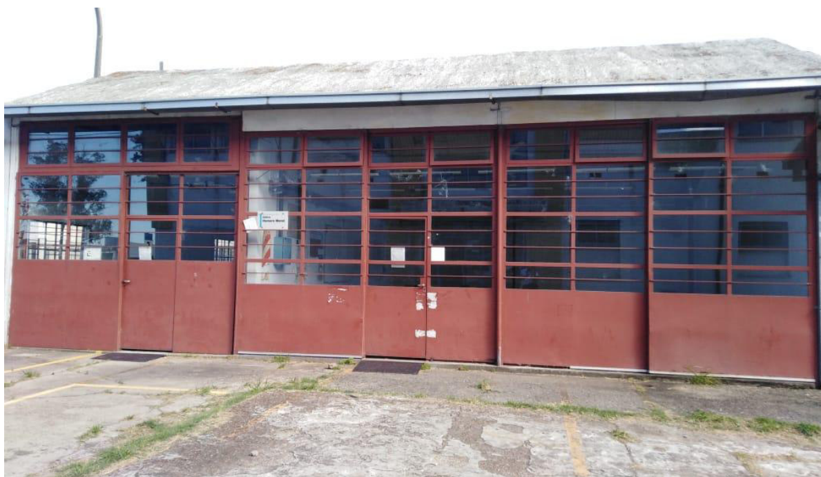
Imagen 2: Vista exterior del edificio.
