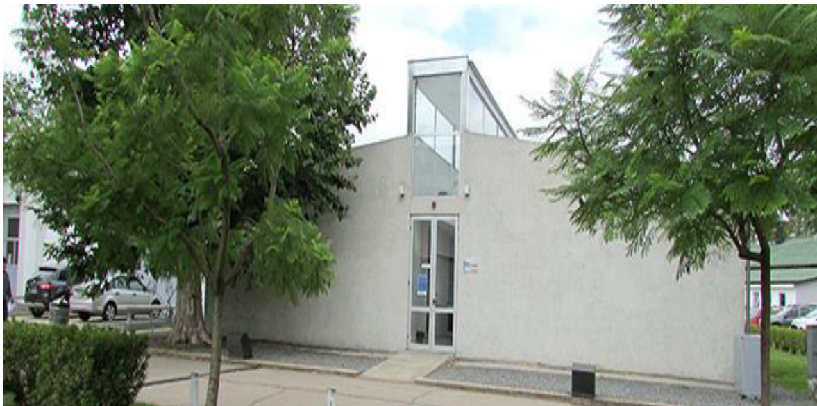
Imagen 1: Vista exterior del edificio.
