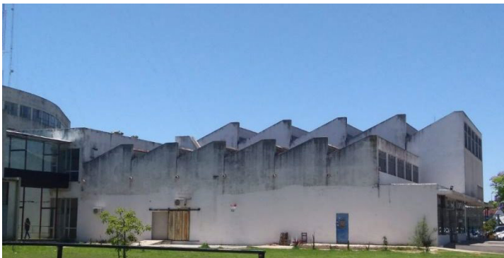
Imagen 9: Vista exterior del edificio.
