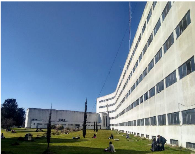
Imagen 3: Vista exterior del edificio.
