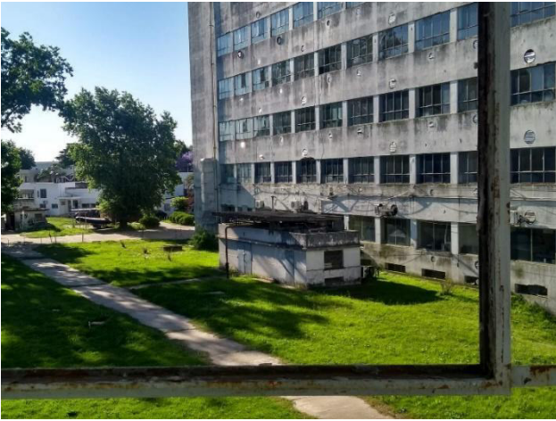
Imagen 1: Vista exterior del edificio.
