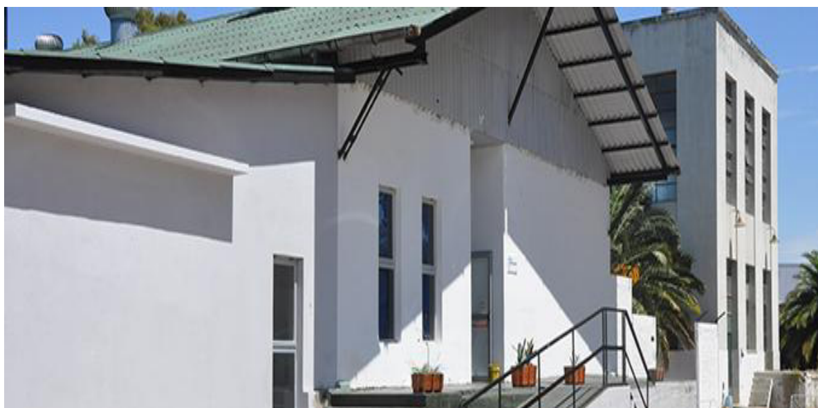
Imagen 1: Vista exterior de la entrada principal del edificio
