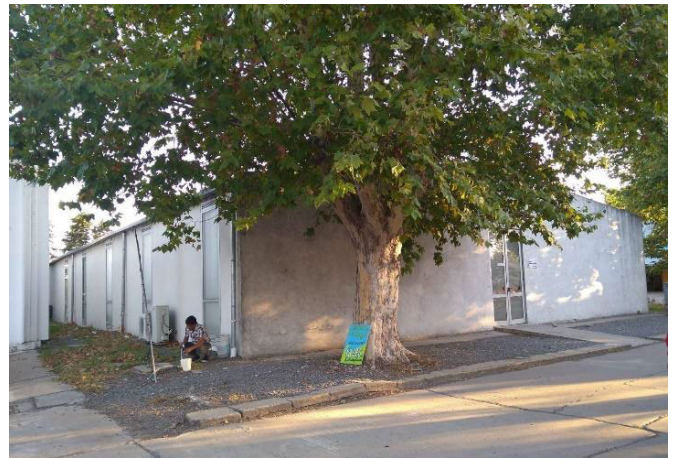
Imagen 3: Vista lado lateral del edificio.
