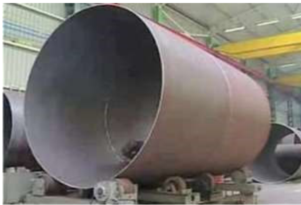
Ilustración 9 Construcción de semi tramo Area 2 Fuente: planta de GRI
